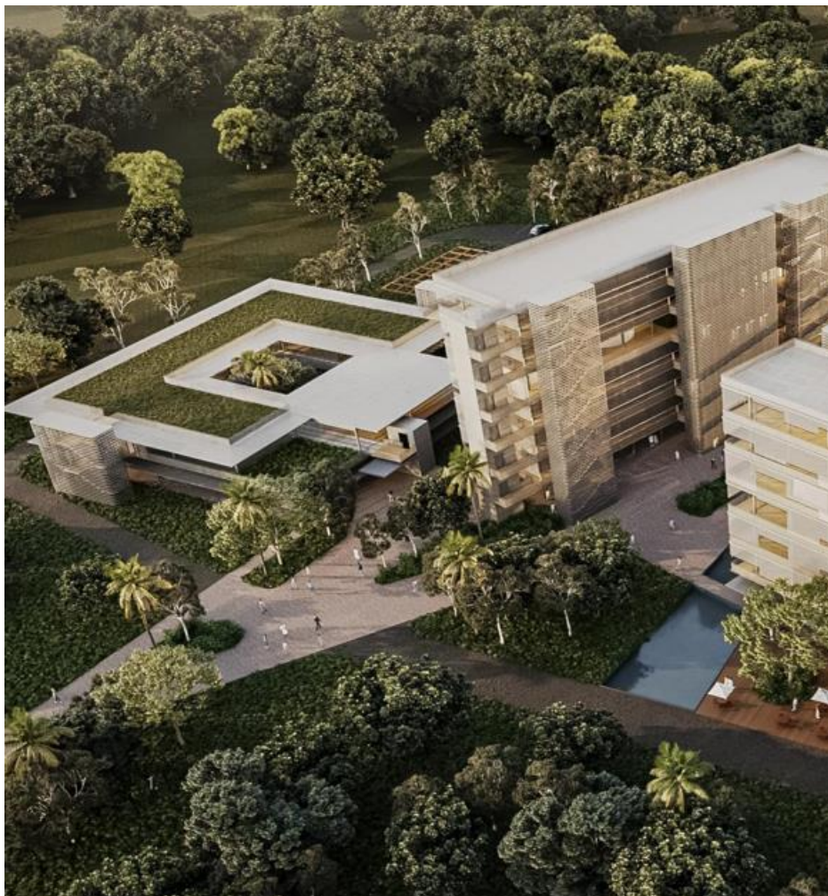
Figura 7: A TSP projetou a construção de prédios conectados entre si e totalmente integrados à vegetação existente, de modo a criar um ambiente de qualidade, agradável e facilitador das atividades de pesquisa e inovação. Crédito: Tishman (Esta imagem é meramente ilustrativa)
